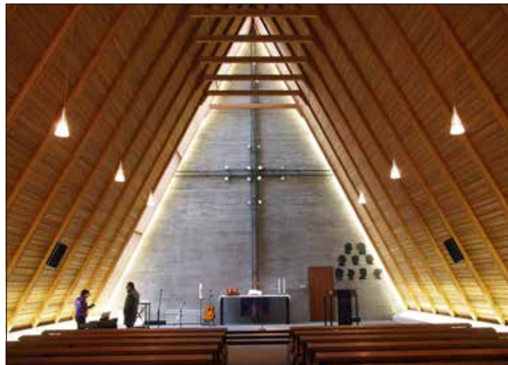
Abb. 2: Diese Kirche im Zeltformat hat auf Grund der geometrischen Form kaum auffallende Raummoden. Zusätzlich entschärfen Holzpaneele als Plattenschwinger und der Teppichboden die Reflexionen. Ein solcher Kirchenraum besitzt beste Voraussetzungen für eine hochwertige multimediale Beschallung.
